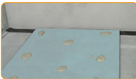
Stendere la colla a tasti sul pannello a terra (collante suggerito Knauf Perlfix)
