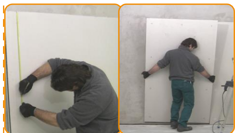
Per ogni pannello di Rewall segnare i punti per 12 tasselli; 4 per lato e al centro a distanza dal bordo di 10 cm ripartiti uniformemente in altezza
