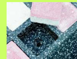
particolare dell'alloggiamento dei tasselli nascosto dal blocchetto in cls.
